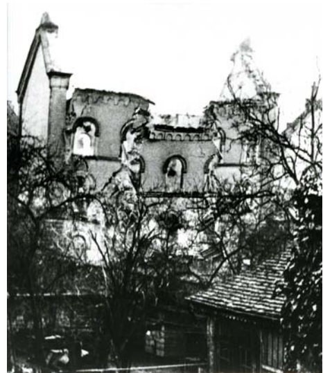
Der letzte Zerstörungsakt: Sprengung der ausgebrannten Synagoge
